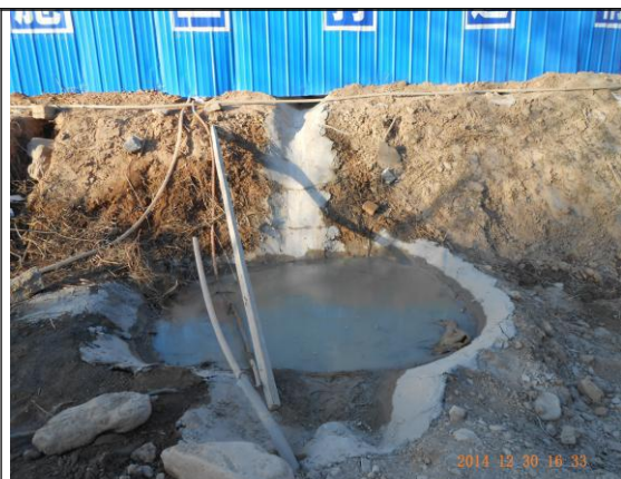
搅拌站设临时沉淀池（监理报告提供）
