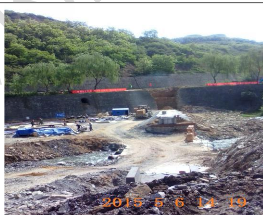
穿越葫芦河设置围堰和导流渠 （监理报告提供）
