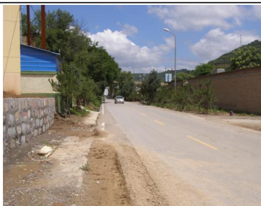
炼油厂公路已恢复（监理报告提供）
