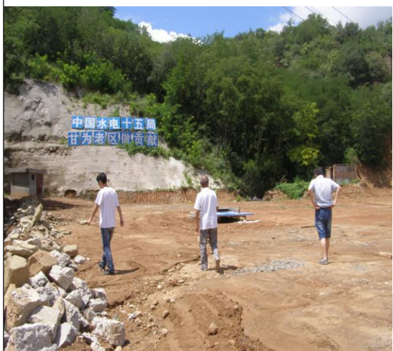
公路西侧支沟恢复情况 （监理报告提供）
